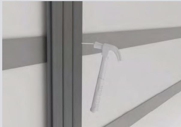
Крепите панели с использованием гвоздей или гвоздезабивного пистолета. Пистолеты для гвоздей обеспечивают более быструю и эффективную установку. Убедитесь, что гвозди размещены равномерно и правильно во время установки. Всегда соблюдайте правила безопасности при использовании гвоздезабивного пистолета.
